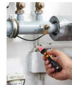
Spannungsüberprüfung an einer Verteilerdose mit testo 745 .
