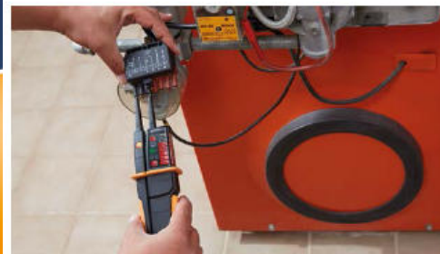
Fehlersuche an der Heizungsanlage mit testo 750 .
