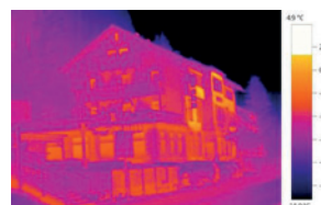
Wärmebild mit testo ScaleAssist
